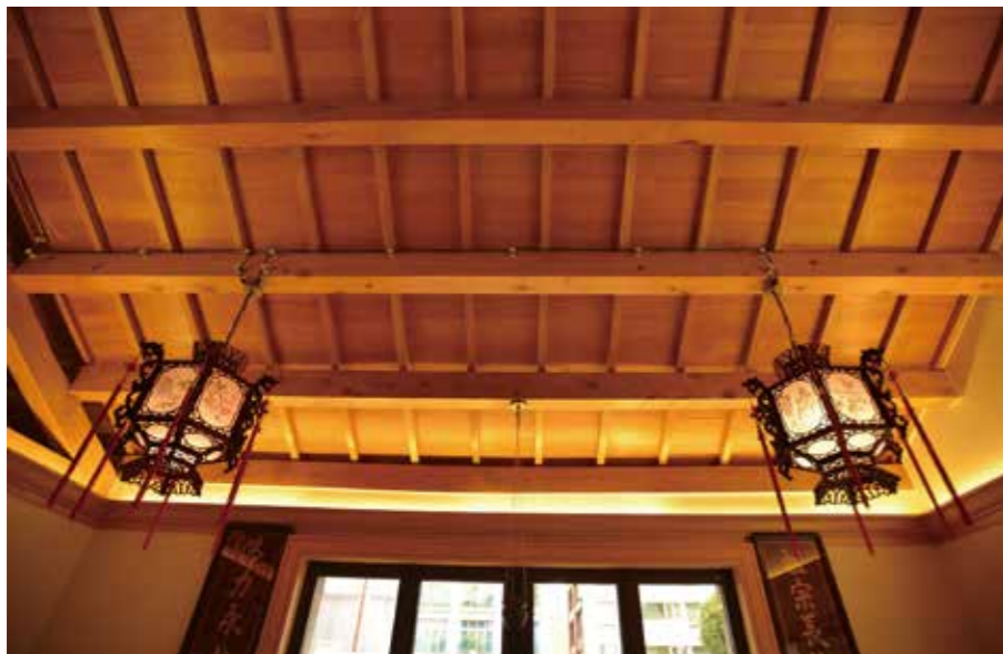
公媽廳屋頂細部
