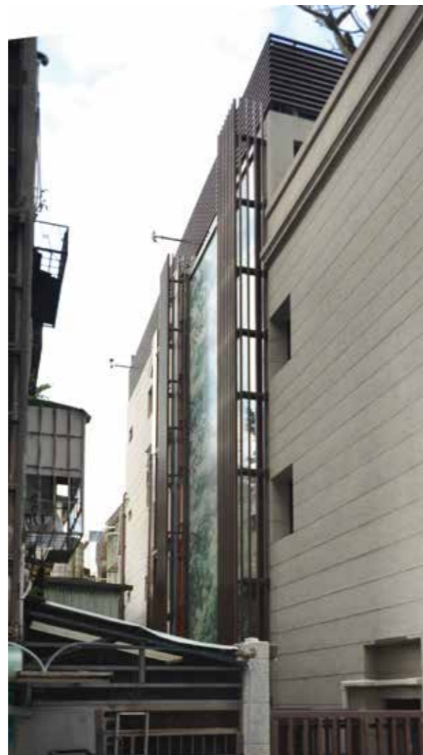
天井電梯帷幕牆室外綠化貼膜
