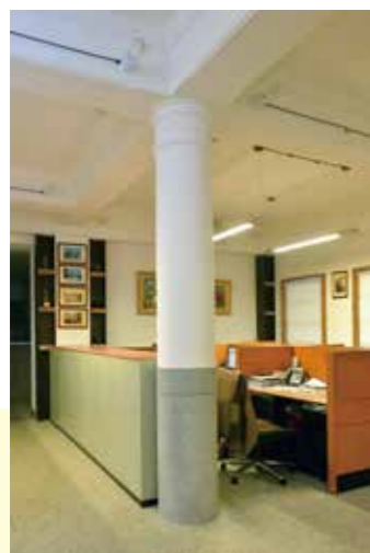
一樓柱梁細部
