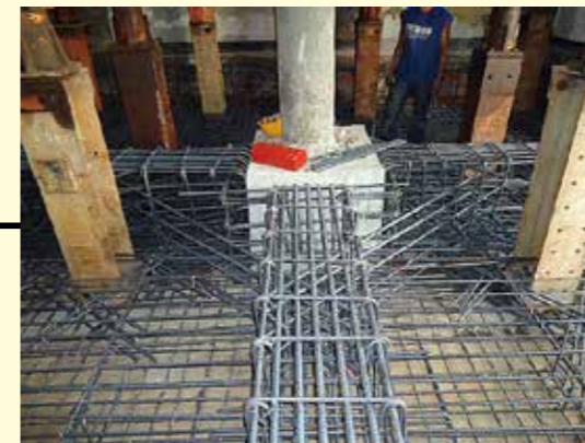
柱基礎與地梁鋼筋綁紮
