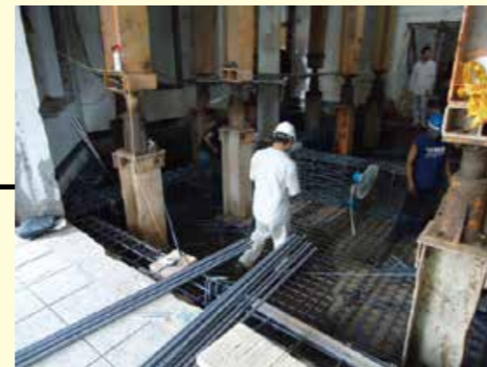
基礎鋼筋綁紮
