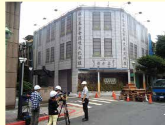
施工時以1:1大圖輸出包覆外觀
