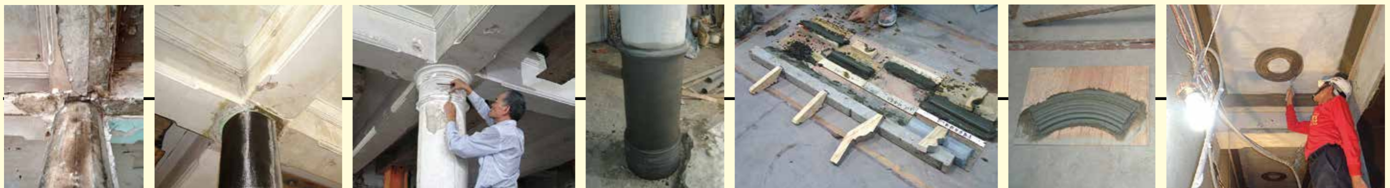
室內柱身表面現況
