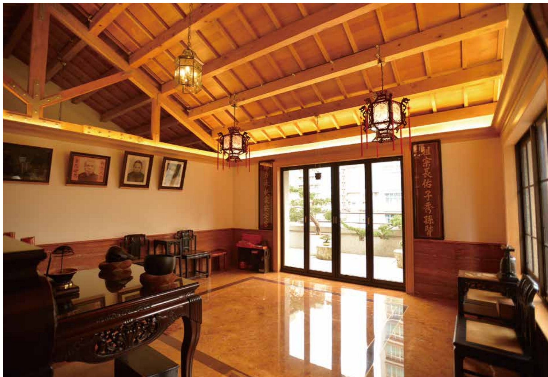
四樓屋頂以臺灣檜木及文化瓦修復
