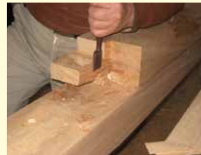
屋架主梁的陽榫鑿製
