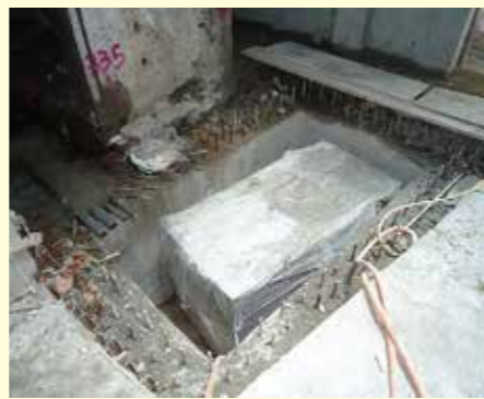
蓄水池外牆置入不銹鋼槽
