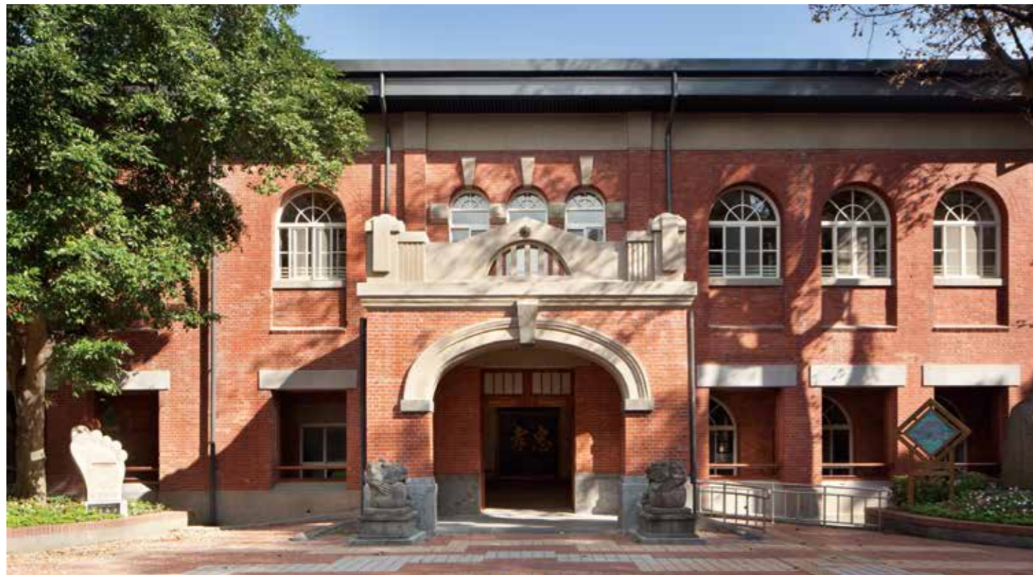
臺北市日新國小歷史建築紅樓復舊整修
