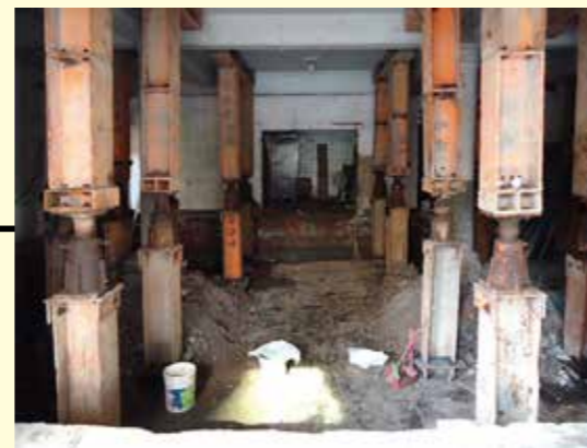
基礎開挖時結構臨時支撐
