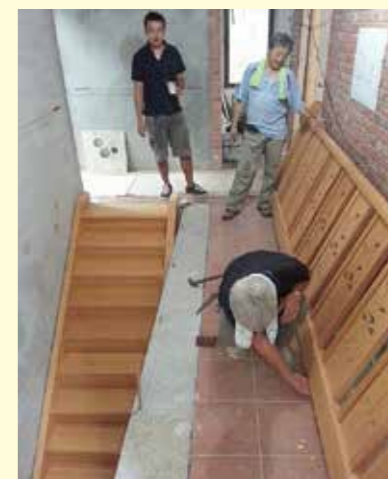
四樓檜木樓梯欄杆組立
