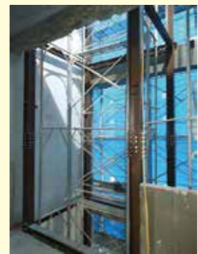
電梯鋼骨支撐安裝
