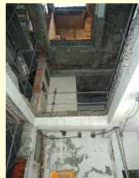
一至四樓電梯間機道
