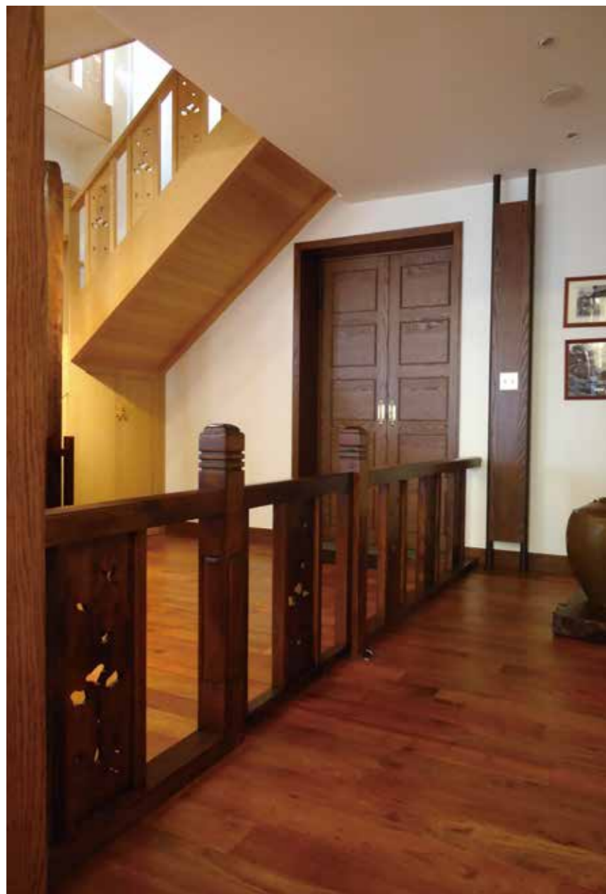
原檜木樓梯欄杆
