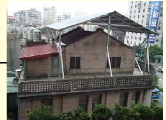
四樓屋頂修護施工棚架
