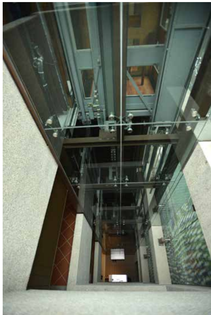
採光天井增設無障礙電梯
