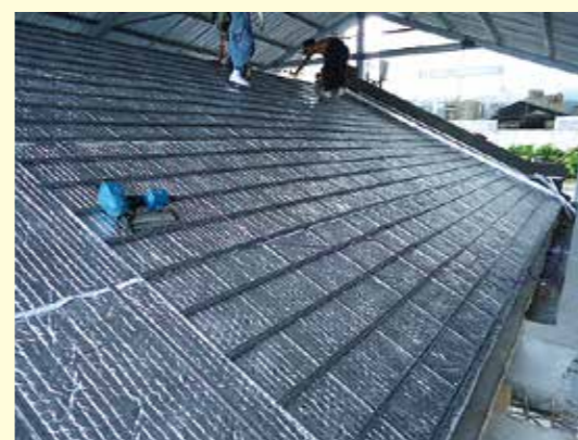
屋頂隔熱層施作
