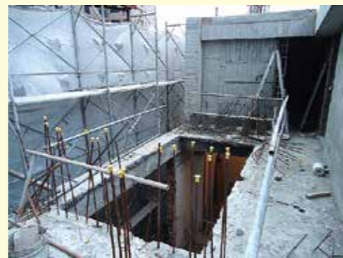
四樓樓電梯間機道
