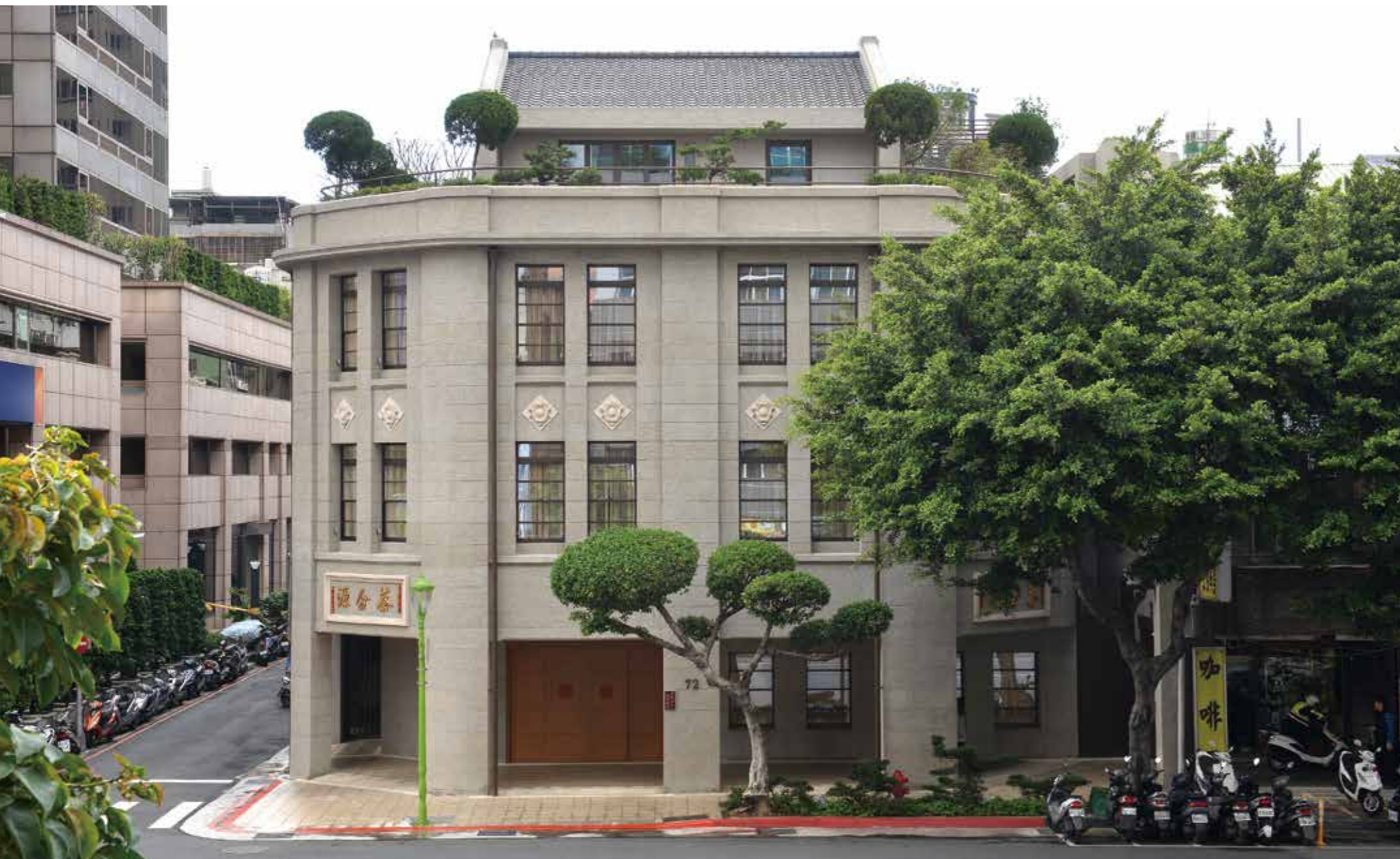
建築特色為不對稱的空間、立面洗石子外牆、水平線腳及幾何圖案的細部與裝飾、大量的開窗等。
