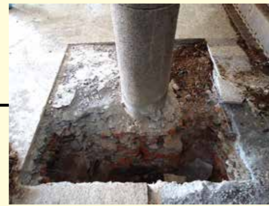
一樓基礎試挖掘
