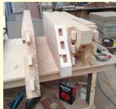
樓梯主架構施作
