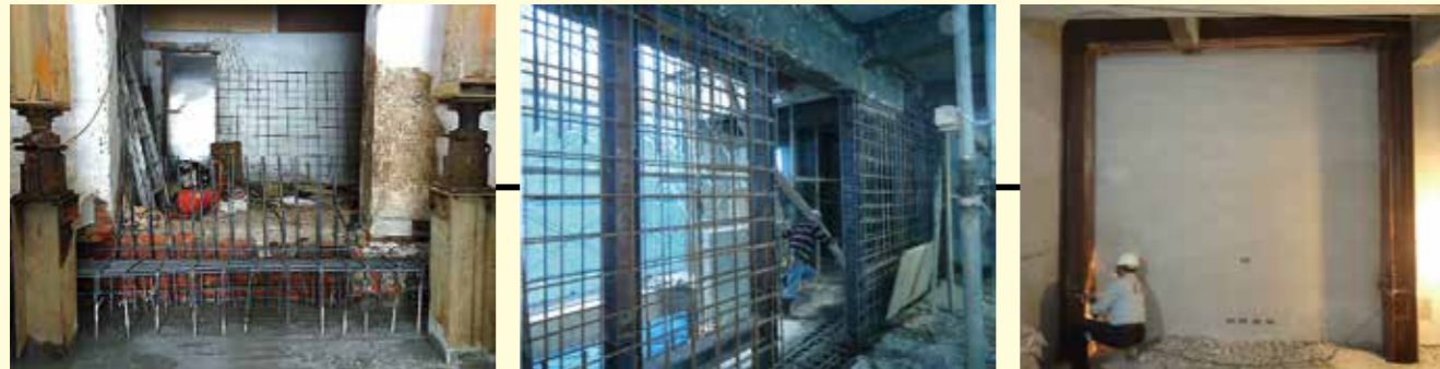
一樓RC剪力牆預留鋼筋
