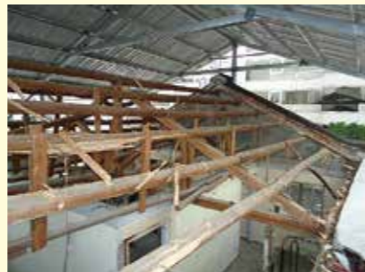
橡木拆除後，拆卸屋桁。
