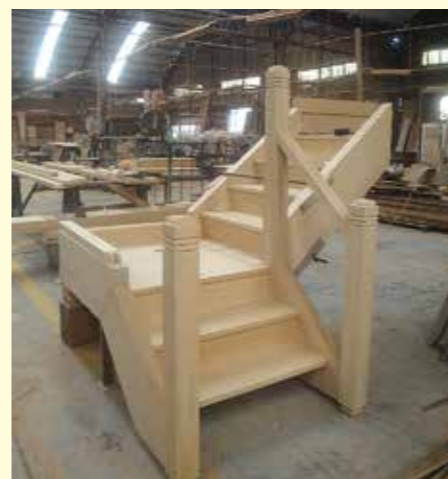
三至四樓檜木樓梯假組立
