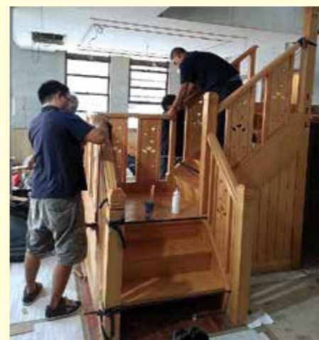
三至四樓檜木樓梯組裝
