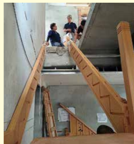
三至四樓樓梯組裝
