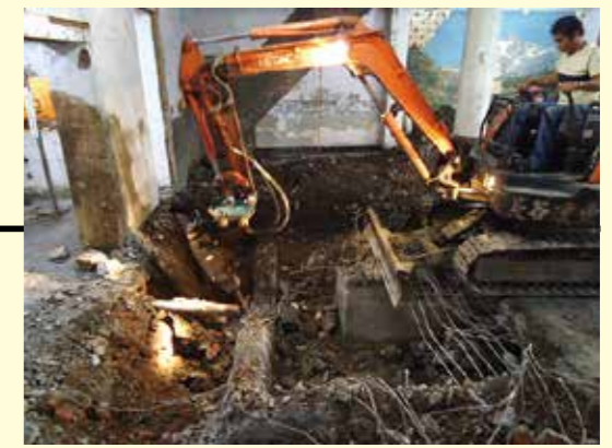
一樓基礎挖掘
