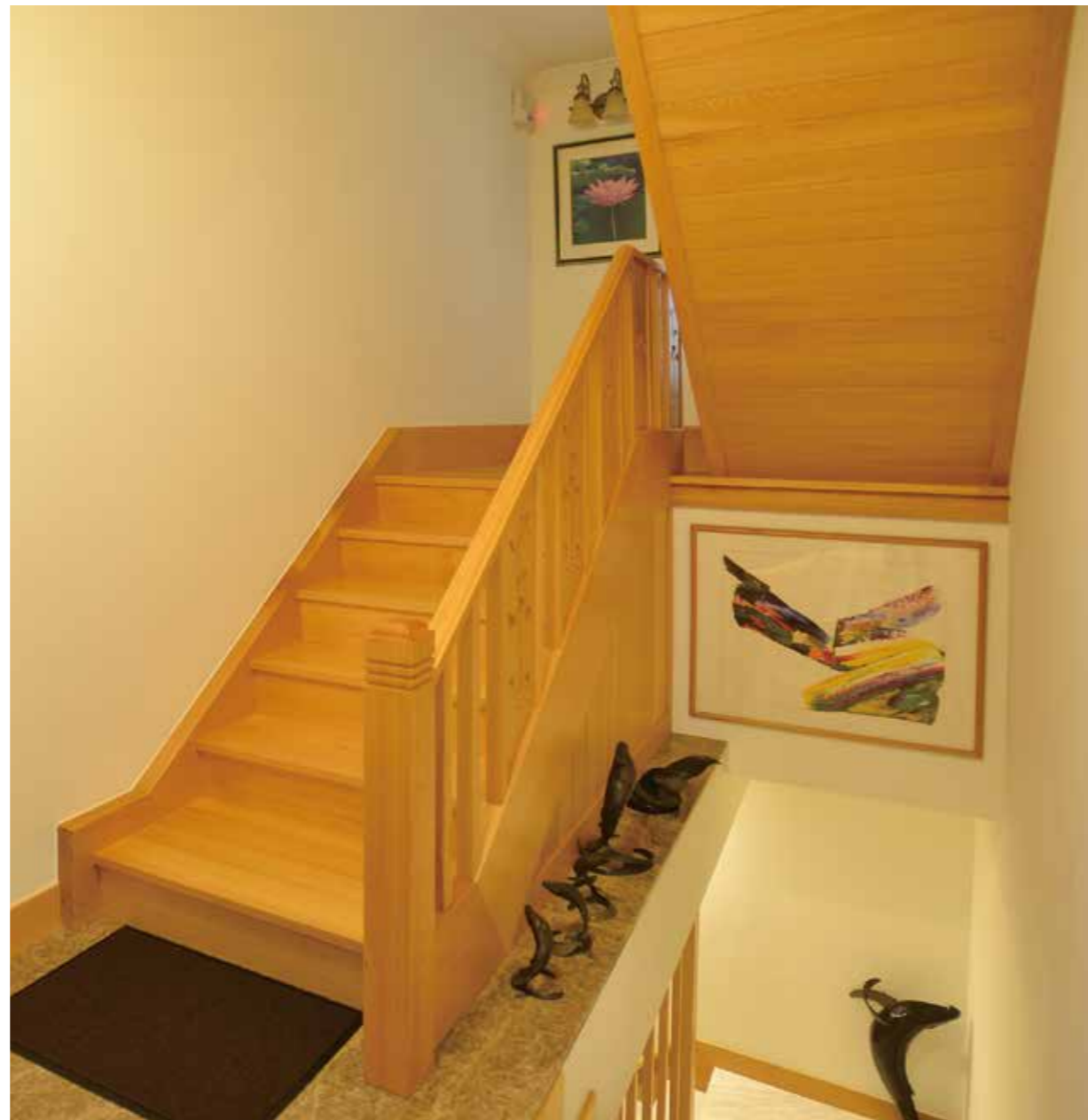
二樓至三樓檜木樓梯
