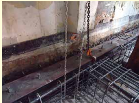
Y向支撐結構地梁安裝
