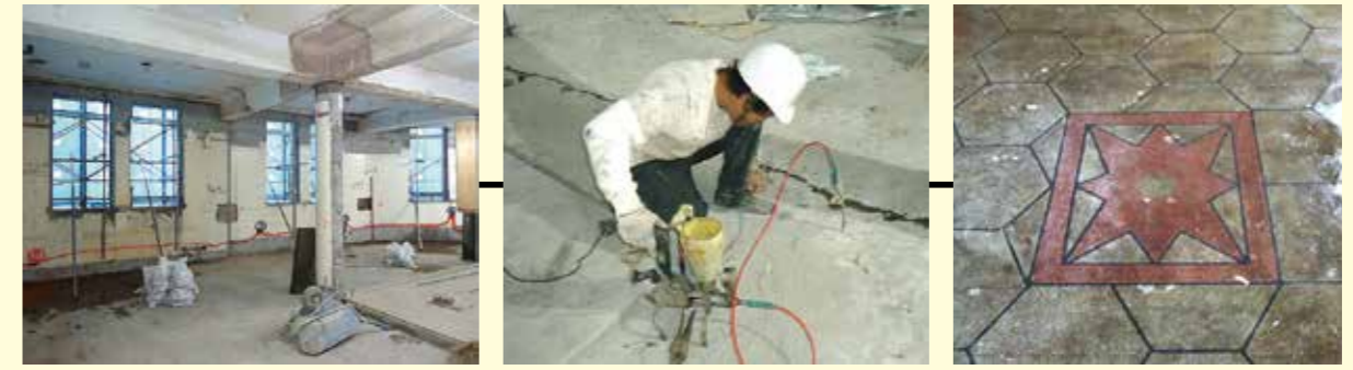
二樓室內地板修復前
