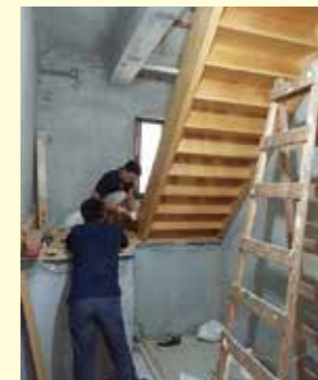
二至三樓樓梯組裝
