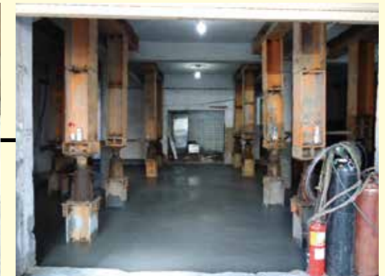
基礎混凝土澆置完成
