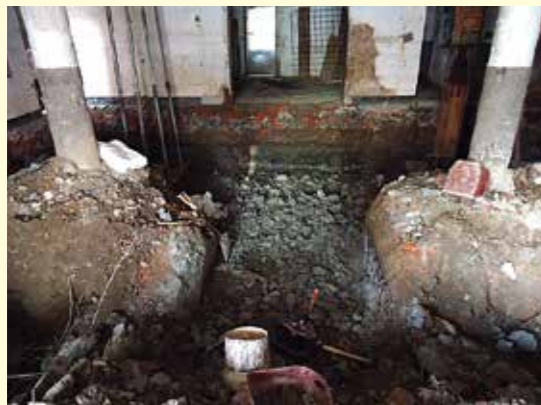
一樓基礎挖掘
