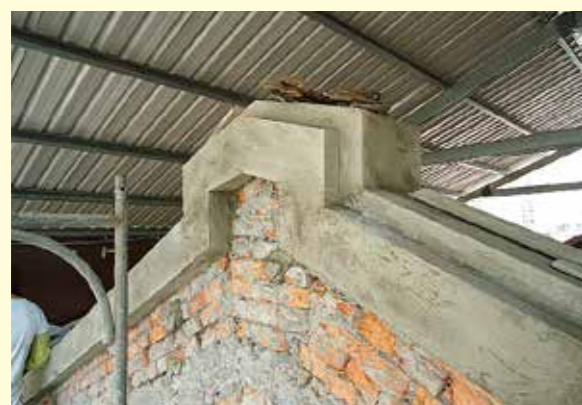
山牆及規帶表面水泥砂漿粉刷重作
