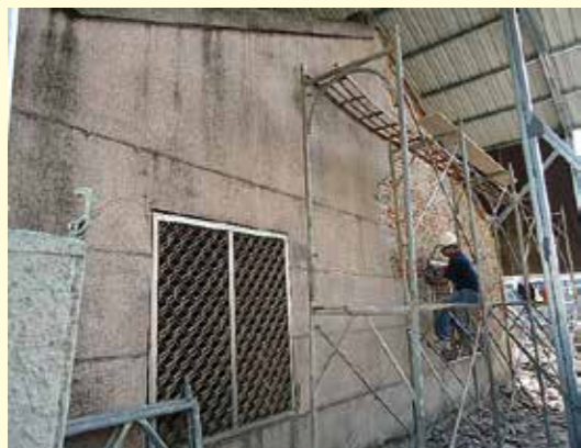
四樓外牆面修復前
