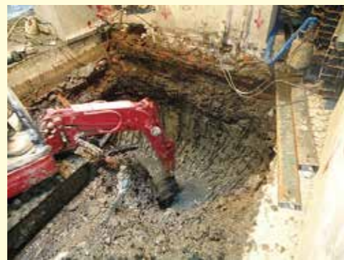
蓄水池基礎開挖
