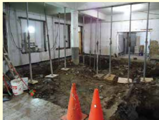
基礎開挖時結構臨時支撐
