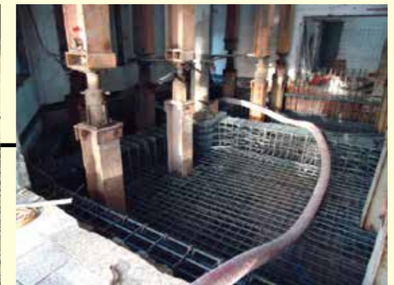
建築物基礎地梁配筋
