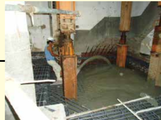
基礎頂版混凝土澆置
