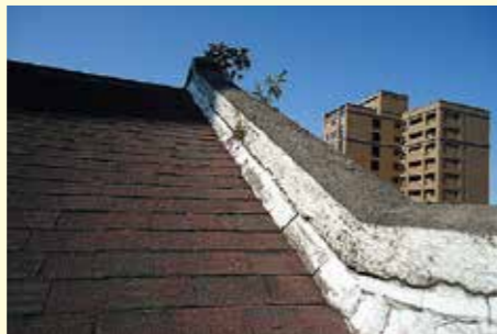
修復前所使用的可樂瓦防水材料
