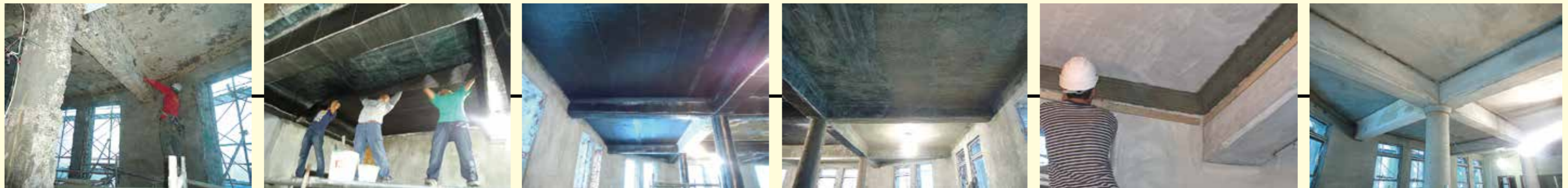
樓板粉刷層敲除
