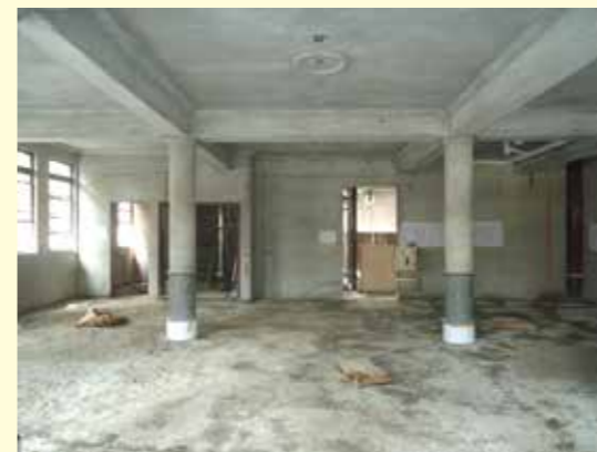
室內牆表面灰作
