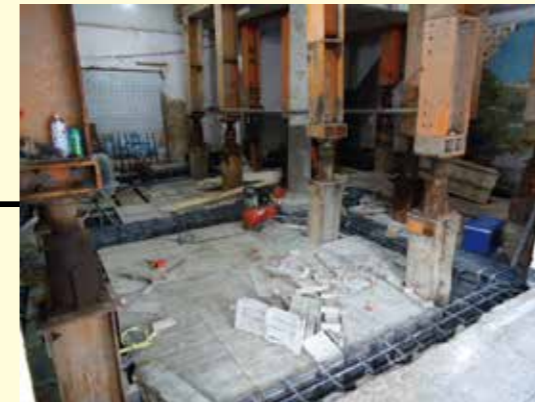
筏式基礎地梁及頂版組模
