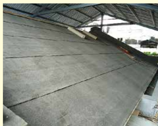
屋頂防水層施作
