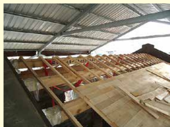
椽木上方由下往上鋪設檜木屋面襯板
