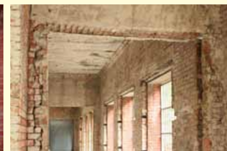
(f) 西側走廊去漆與更換破損磚材
