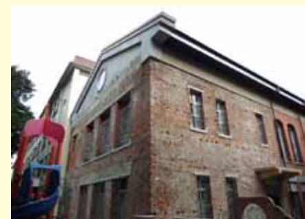
教具棟外牆粉刷層拆除
