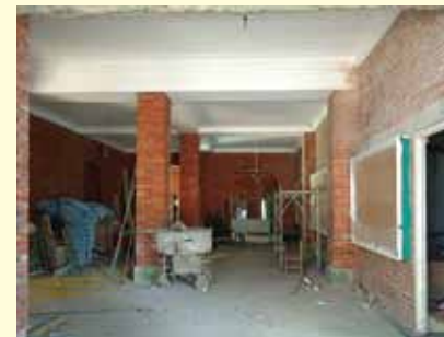
南側川堂整修中
