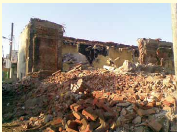
拆除具有95年歷史的蔡合源基隆冷凍廠
