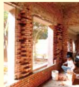
使用回收之 TR 磚填補 (f)
