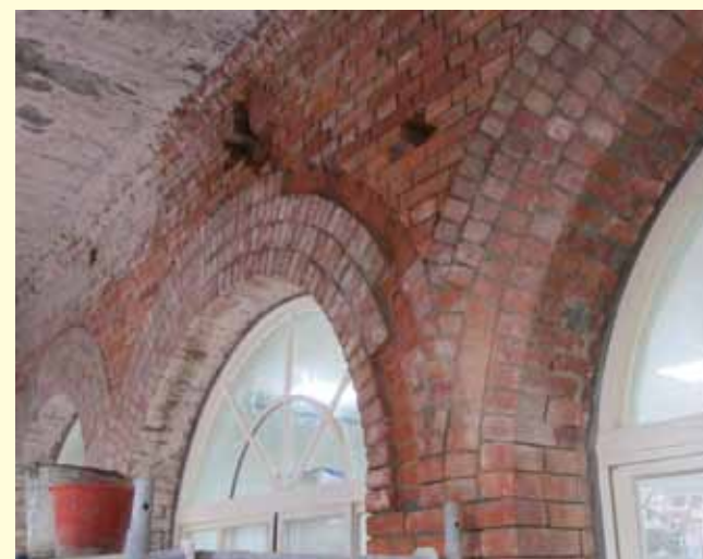
原牆面內之管線清除並整磚 (f)
