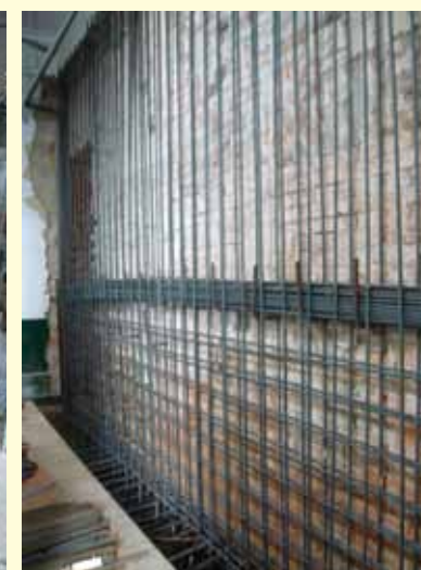
(a) 剪力牆鋼筋植筋
