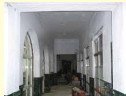
一樓西側廊道白色油漆牆面原況
