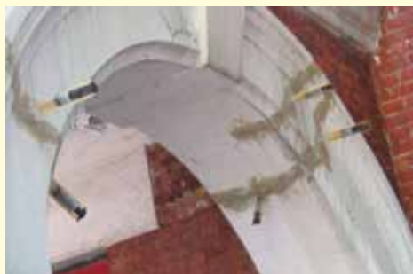
(f) 圓拱裂縫低壓灌注補強
