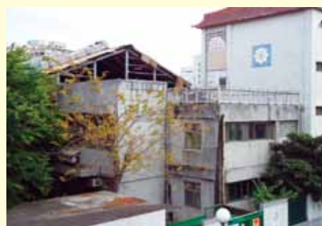
文道圖書館拆除前
