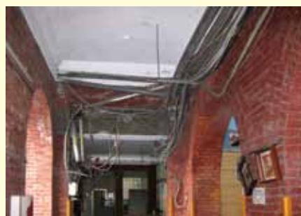
東側走廊管線原況
