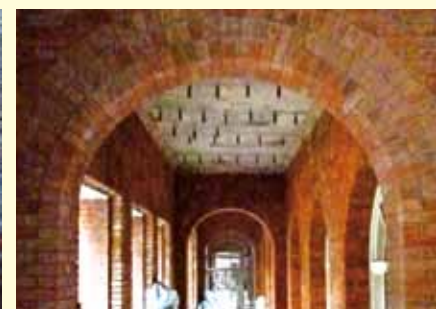
EPOXY 低壓裂縫補強
