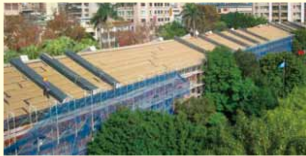
鋼瓦屋頂施作中
