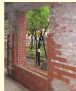
使用回收之 TR 磚填補 (f)
