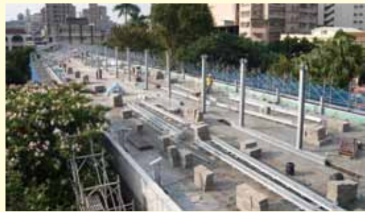
新建屋頂鋼骨結構施工中
